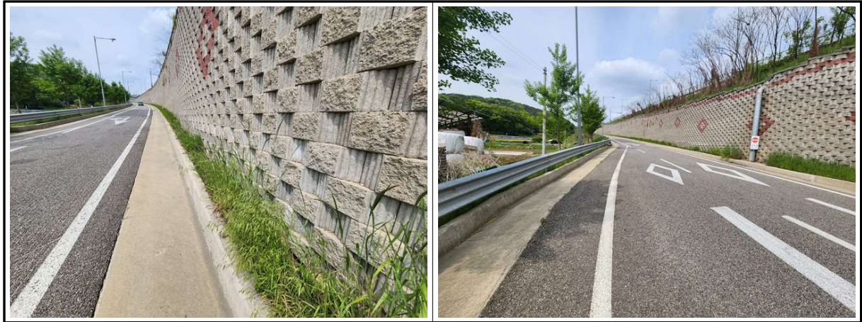
【사진 3.3.1】 지반, 기초부 전경
