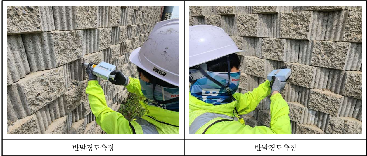
【사진 3.4.1】 재료시험 조사 전경
