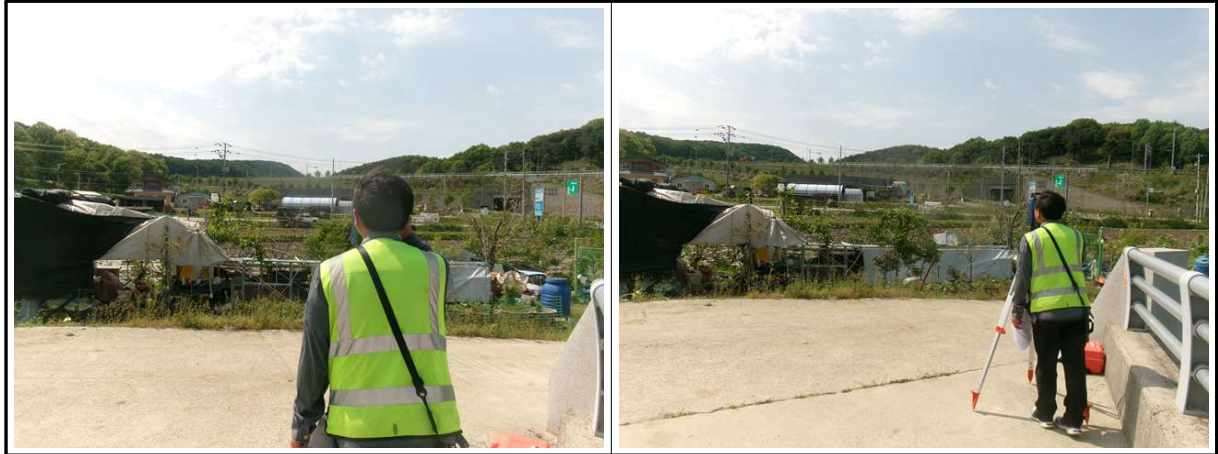
【사진 3.4.2】 측량작업 전경
